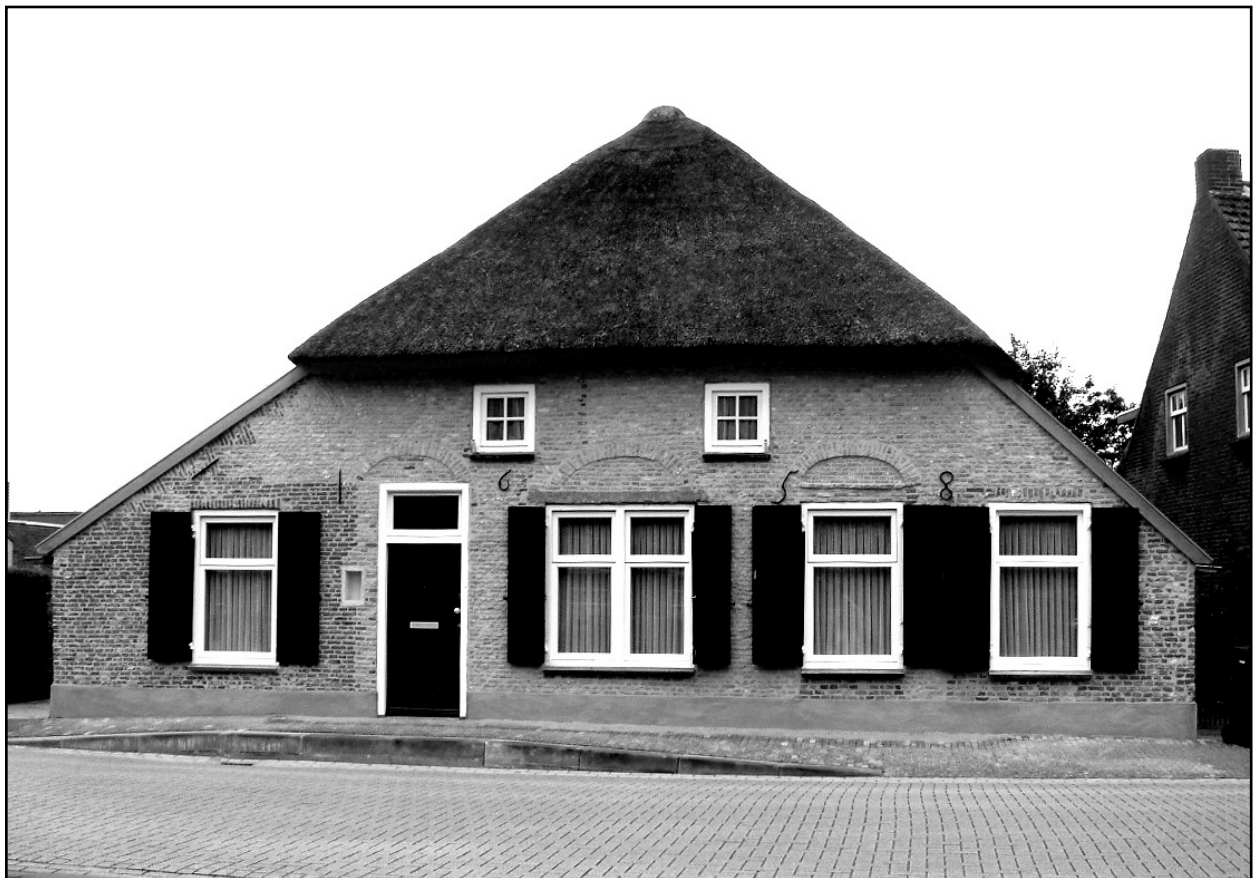
Maaskantje 57 na restauratie van de voorgevel. Tijdens de herstelwerkzaamheden in 2007 kwamen oude ontlastingsbogen (korfbogen) te voorschijn ( foto Jos van Thiel).
